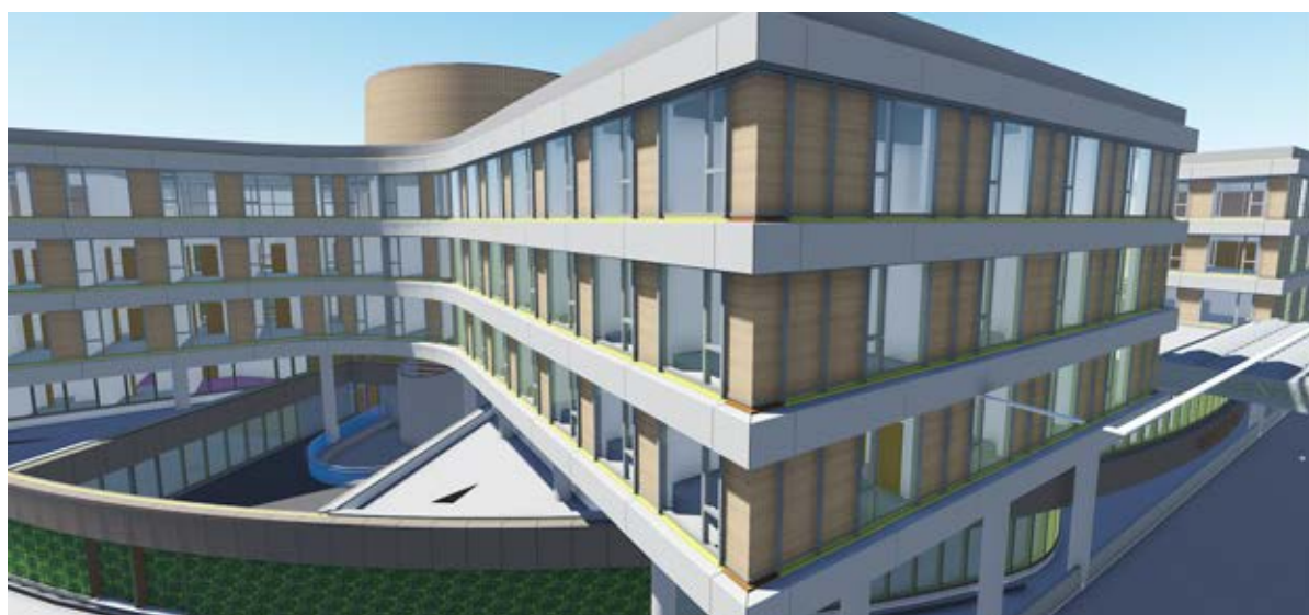
Centre hospitalier Chirec, Bruxelles
